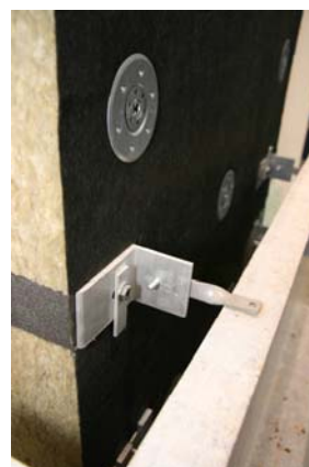
Abb. 11 thermisch entkoppelter Haltepunkt
