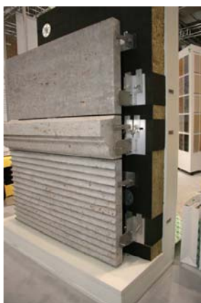
Abb. 10 thermisch entkoppelte Fassade
