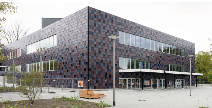
Projekt: Fassadensanierung-/ Neugestaltung Stadthalle Göttingen Architektur: soll sasse architekten BDA Foto: Eberhard Sasse / Niklas Richter
