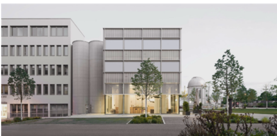
Projekt: Biotechnologiezentrum Tübingen Architektur: RIEHLE KOETH Foto: Brigida González
