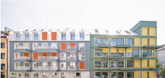
Projekt: Wohn- und Bürogebäude „Vinzent“, München Architektur: allmannwappner gmbh Foto: Kim Fohmann
