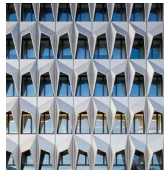
Preisträger »Deutscher Fassadenpreis 2013 für VHF«: Hochhaus C10, Hochschule Darmstadt Staab Architekten, Berlin Foto: Werner Hutmacher, Berlin
