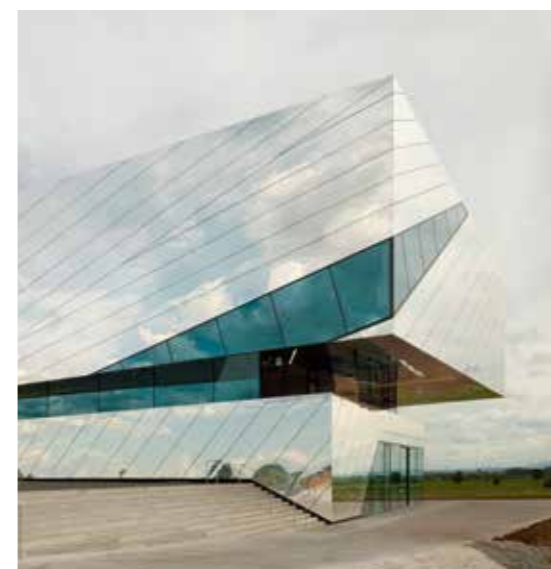
Anerkennung »Deutscher Fassadenpreis 2013 für VHF«: Palaeon, Schöniger Speere Holzer Kobler Architekturen, Zürich Foto: Jan Bitter, Berlin
