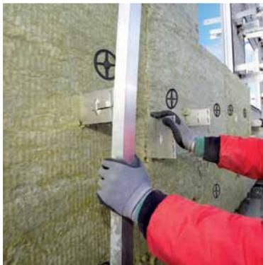
Die Steinwolle-Dämmplatte Fixrock 033, das Top-Produkt von ROCKWOOL für die VHF, bietet mit einer Wärmeleitfähigkeit von  $\lambda = 0,033\text{ W/(m}\cdot\text{K)}$  den besten Wärmeschutz, den eine Steinwolle-Fassadendämmplatte bieten kann. Durch ihre wasserabweisende Eigenschaft ist Fixrock 033 für den Einsatz in VHF bestens geeignet.
