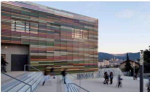
Barro-Stabziegel. Neben seiner Funktion als architektonisches Fassadenelement dient der Stabziegel auch als Sonnenschutz und Sichtblende. Damit lassen sich Erfordernisse des sommerlichen Wärmeschutzes mit gestalterischen Ansprüchen ideal vereinen. Der Barro besticht durch vielfältige Formvarianten und ein nahezu unbegrenztes Farbspektrum.
