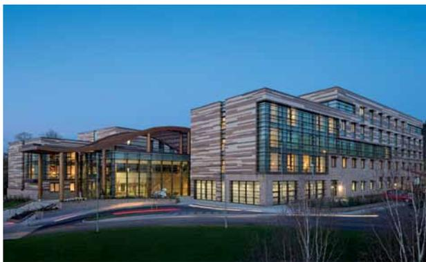
KeraTwin® und KerAion® – Keramische Fassadensysteme für besonders rationelle Verlegung und praktisch unbegrenzte Einsatzmöglichkeiten dank unterschiedlicher Befestigungssysteme, auch auf schwierigen Untergründen. Große Farbpalette und Formatvielfalt bis Großformate 180 x 50 cm bzw. 120 x 120 cm. Statisch vorteilhaft durch ein geringes Platten-gewicht.
