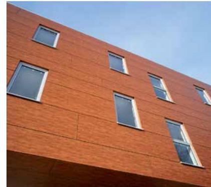
Die Max Exterior Platte ist ein hochwertiges Bauprodukt, das als großformatige Platte speziell für dauerhafte Fassaden- und Balkonbekleidungen verwendet wird. Max Exterior sind duromere Hochdrucklamine (HPL) nach EN 438-6, Typ EDF mit einem wirksamen Witterungsschutz. Ihre Erzeugung erfolgt in Laminatpressen unter großem Druck und hoher Temperatur.
