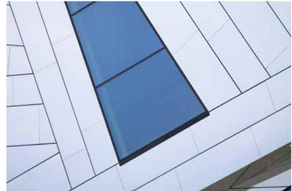
Das MBE- Fassadenklebstoffsystem ist ein Klebesystem für die nicht sichtbare Montage von Fassadenplatten. Das System besteht aus dauerelastischem Klebstoff MBE Panel Loc, einem doppelseitig klebenden Montageband zur Fixierung der Platten und entsprechenden Produkten zur Vorbehandlung der Untergründe.
