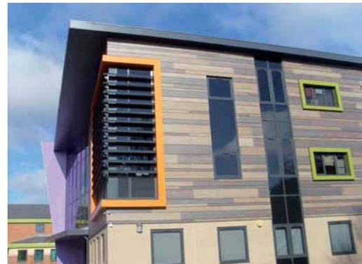
ROCKPANEL Tafeln in ‚FS-Xtra‘ Qualität erfüllen, auf einer Aluminium- oder Stahl-Unterkonstruktion befestigt, die Anforderungen der europäischen Baustoffklasse A2-s1, do. Wie alle ROCKPANEL Produkte vereinen sie die Vorteile von Stein und Holz: Sie sind besonders witterungs-, temperatur- und UV-beständig, einfach zu biegen und tordieren.
