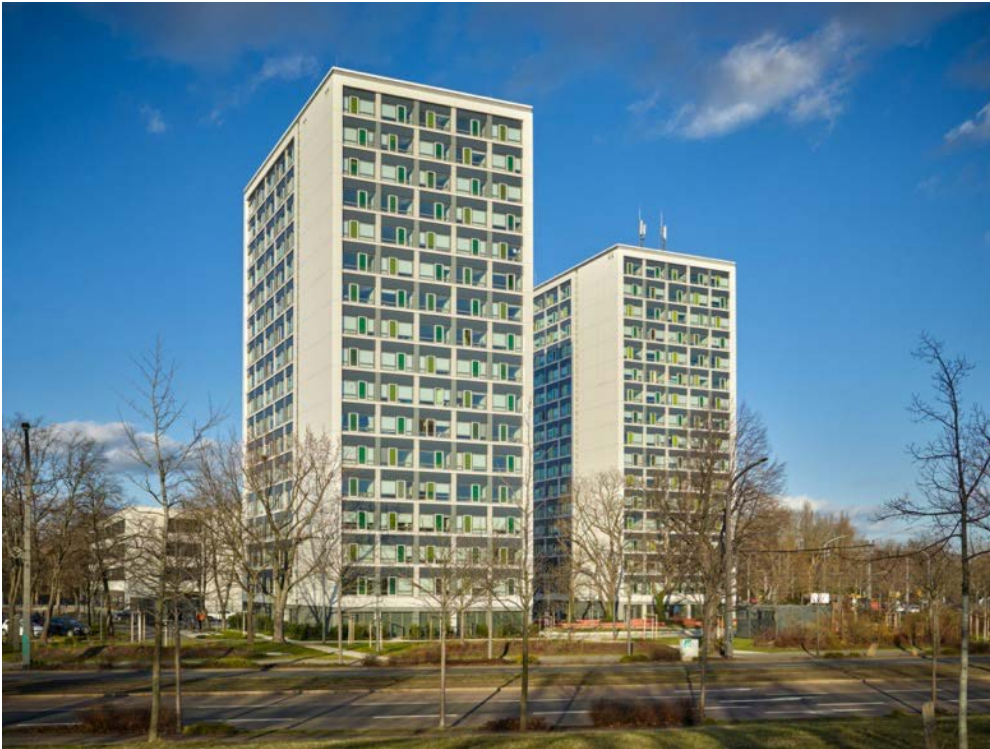
Projekt: Hochhäuser Gret-Pallucca-Straße 9 und 11 in Dresden Architektur: S&P Sahlmann Planungsgesellschaft für Bauwesen mbH Foto: Lothar Sprenger
