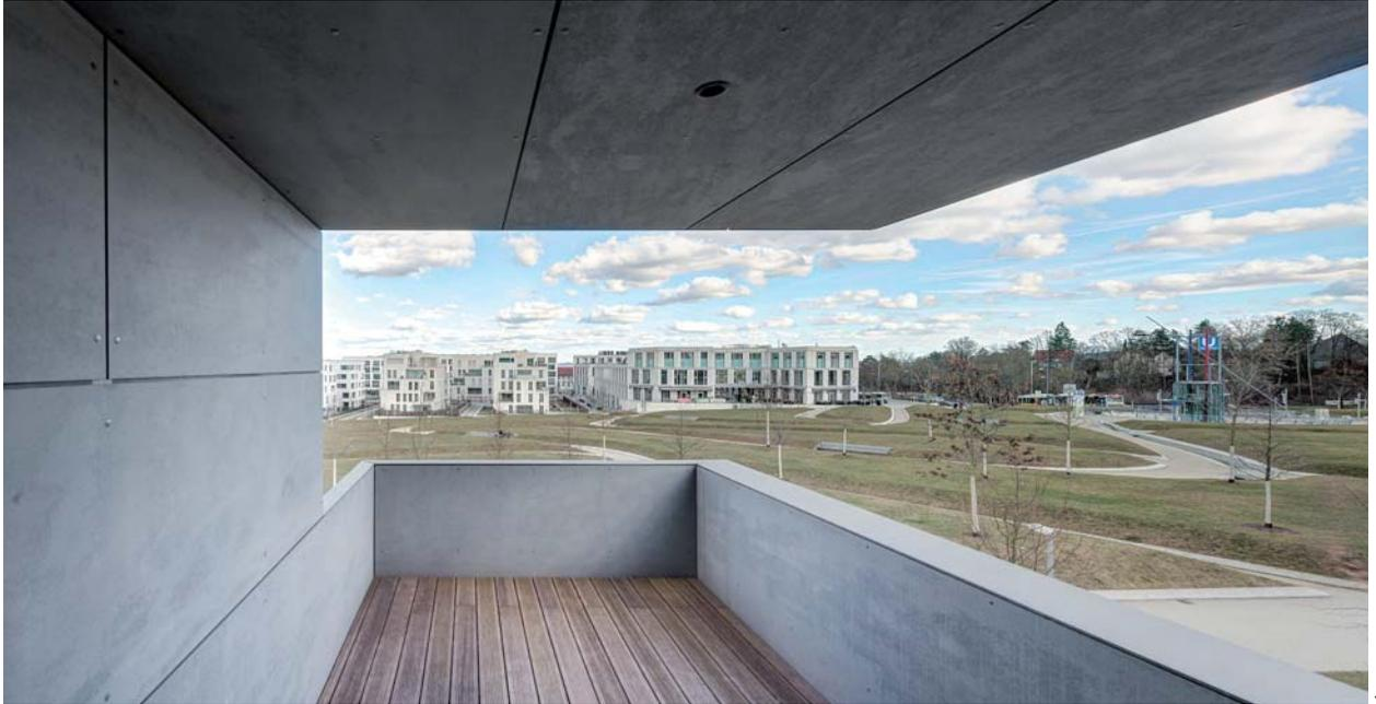
Die Architekten begreifen die beiden Bauten als Skulptur und legen besonderes Augenmerk auf Fugenverlauf und Anordnung der sichtbar befestigten Fassadentafeln. Alle technisch notwendigen Zu- und Abluftöffnungen verschwinden im Hinterlüftungsraum unsichtbar unter perforierten und gelaserten Fassadentafeln.
