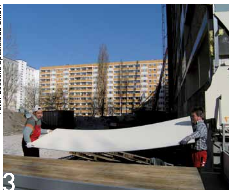
Foto: Bösecke Spezialbau GmbH
