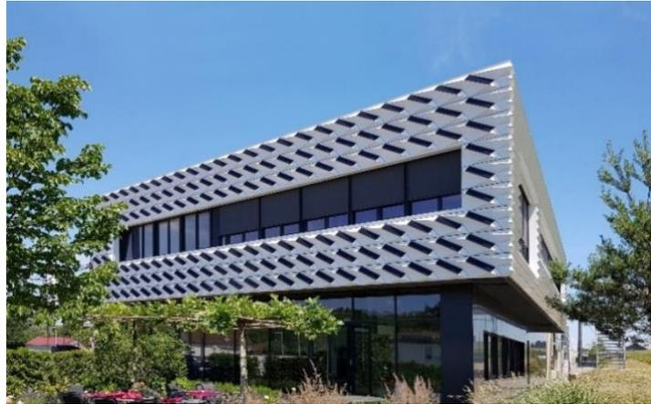
Abbildung 10/11: SOLAR.shell Photovoltaikfassaden am Bürotrakt der Aluform GmbH, Bad Rappenau. Ansicht der Westfassade und Eckausbildung Süd-West. Projektleitung: Architektur-Institut der HTWK Leipzig (ai:L), (Fotos Frank Hülsmeier)
