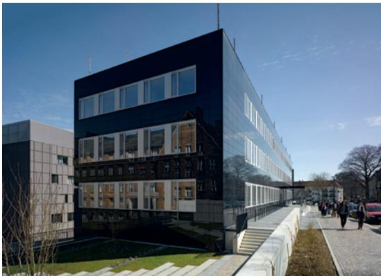
**8** Energie selbst herstellen – mit in der Fassade integrierten Solarpaneelen kein Problem: Beispielhaft ist der Einsatz am Walther-Hempel-Bau der TU Dresden, der im Rahmen einer energetischen Sanierung zum eleganten Energieproduzenten wurde.
