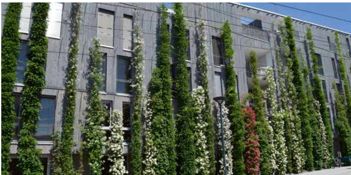
01_Wandgebundene Fassadenbegrünung als Vorgehängte und Hinterlüftete Fassade Kindergarten Augartenstraße, Karlsruhe
