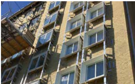
Beim renovierten Gebäudeensemble AAB Kopenhagen sorgen Installationen im Hinterlüftungsraum für zusätzlichen Wohnraum. Die Renovierung konnte im bewohnten Zustand durchgeführt werden.
