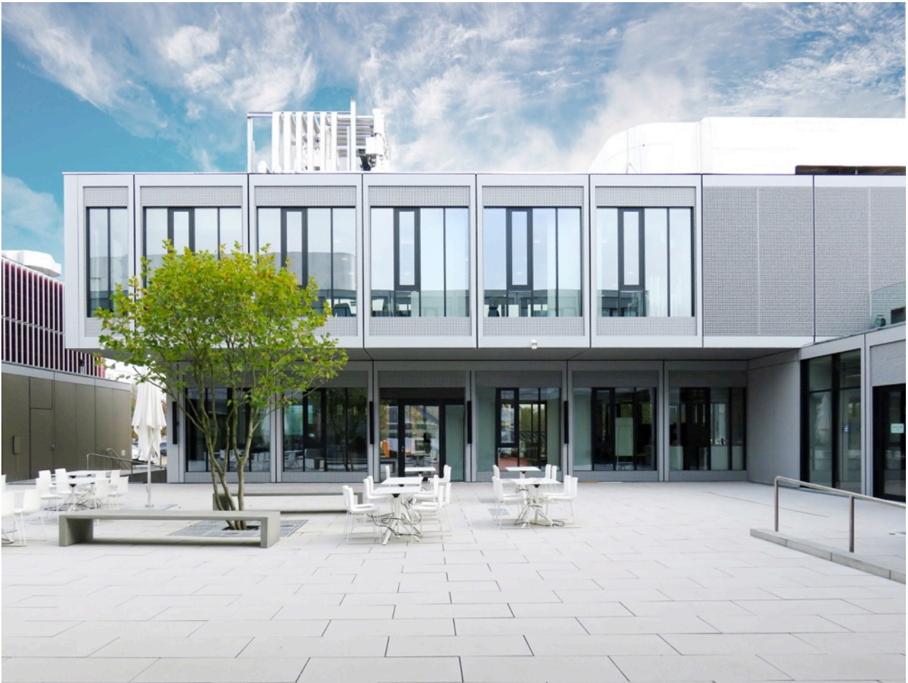
Modulares Innovationszentrum für das Wissenschafts- und Technologieunternehmen Merck. Architekten: HENN GmbH Foto: ADK Modulraum GmbH
